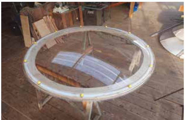
toono ouvrant en Altuglas 2mm
