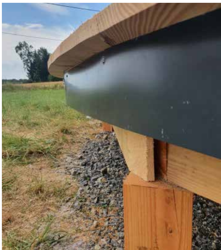
Protection du solivage bas par bac acier de 12 cm
