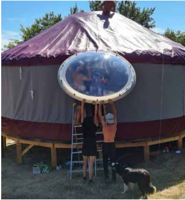
Installation d'une bulle plexi
