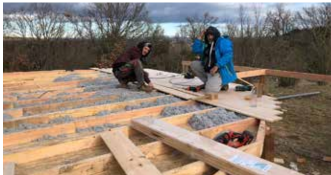
Isolation en ouate de cellulose
