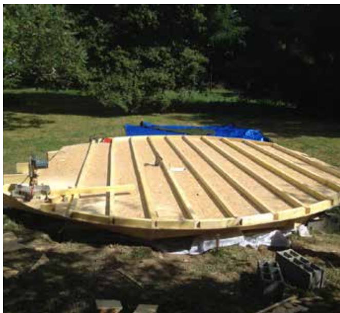
Solivage haut + osb, prêt à mettre l'isolation
