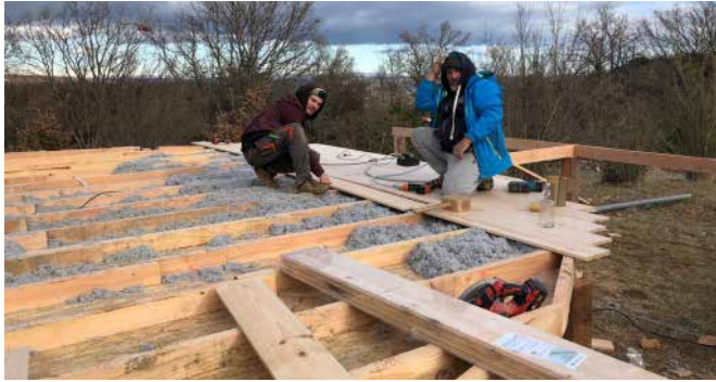
Isolation en ouate de cellulose
