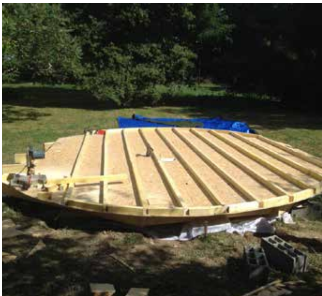
Solivage haut + osb, prêt à mettre l'isolation
