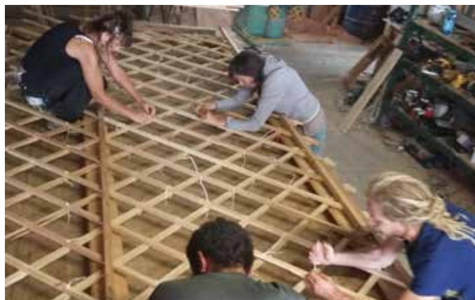
Fabrication d'un treillis
