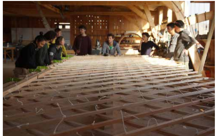
Fabrication d'un treillis
