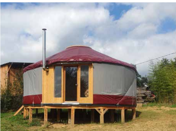
Sortie de poêle à bois sécurisé
