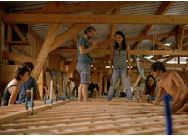
Fabrication du treillis
