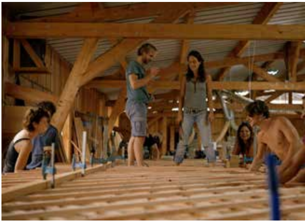
Fabrication du treillis
