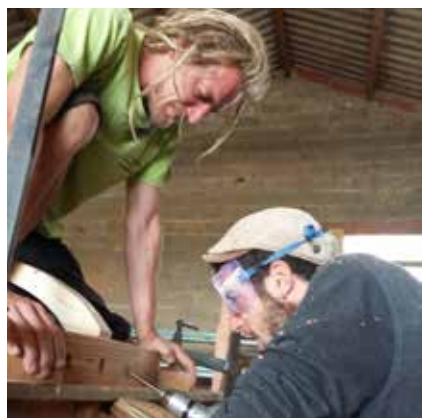
Perçage du toono
