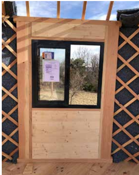
Fenêtre alu coulissante sur châssis bardé
