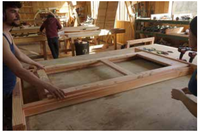
Fabrication des portes
