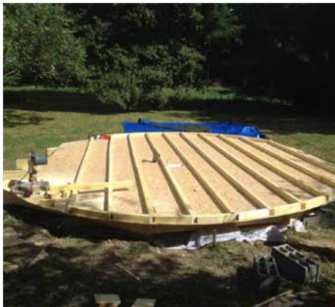
Solivage haut + osb, prêt à mettre l'isolation
