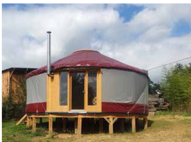
Sortie de poêle a bois sécurisé
