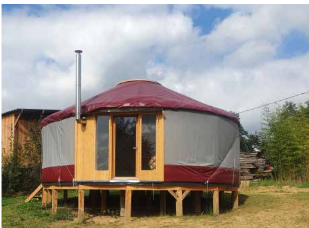
Sortie de poêle à bois sécurisé
