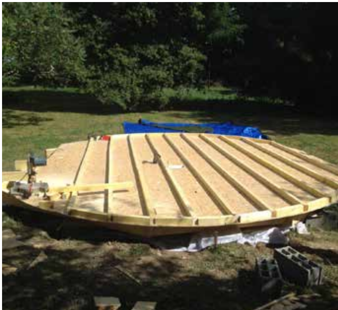
Solivage haut + osb, prêt à mettre l'isolation
