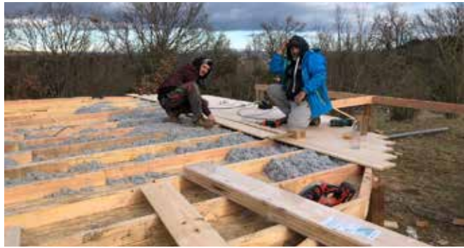
Isolation en ouate de cellulose
