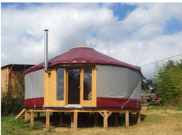
Sortie de poêle à bois sécurisé
