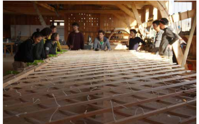
Fabrication d'un treillis en autoconstruction
