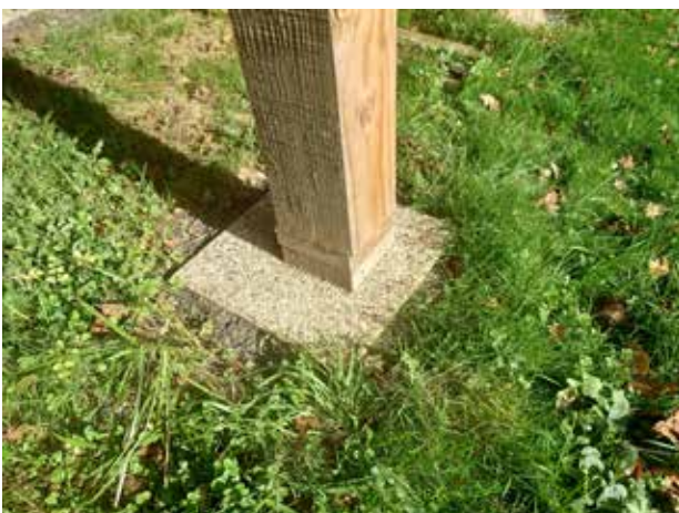
Pilotis bien au sec sur un socle amovible en béton
