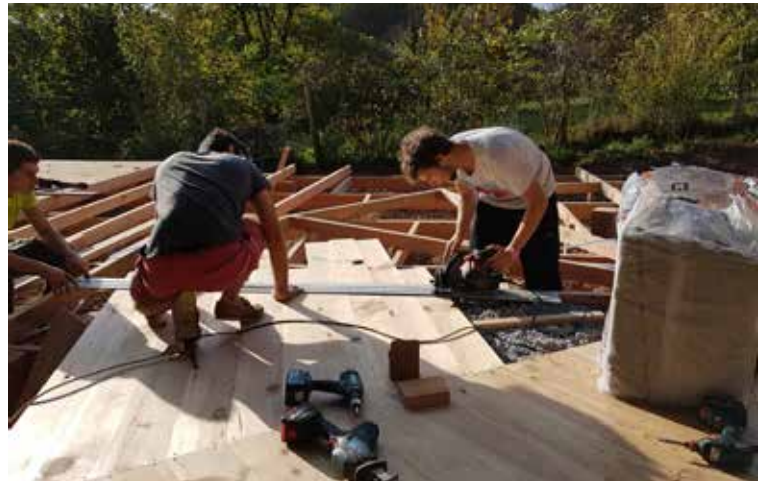
Pose du plancher en étoile (très long à faire, mais très beau)
