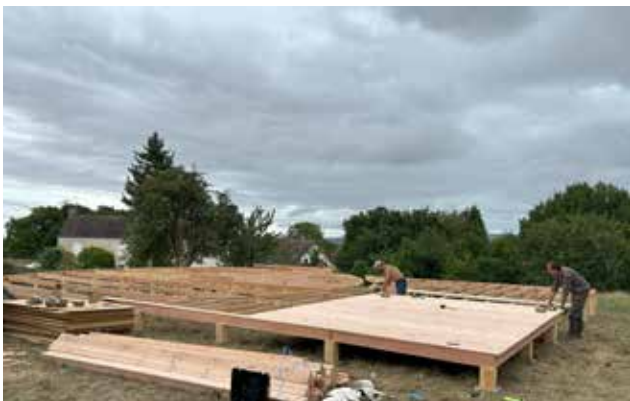
Fabrication plancher et terrasse
