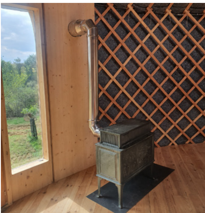
Sortie poelle à bois avec laine de roche
