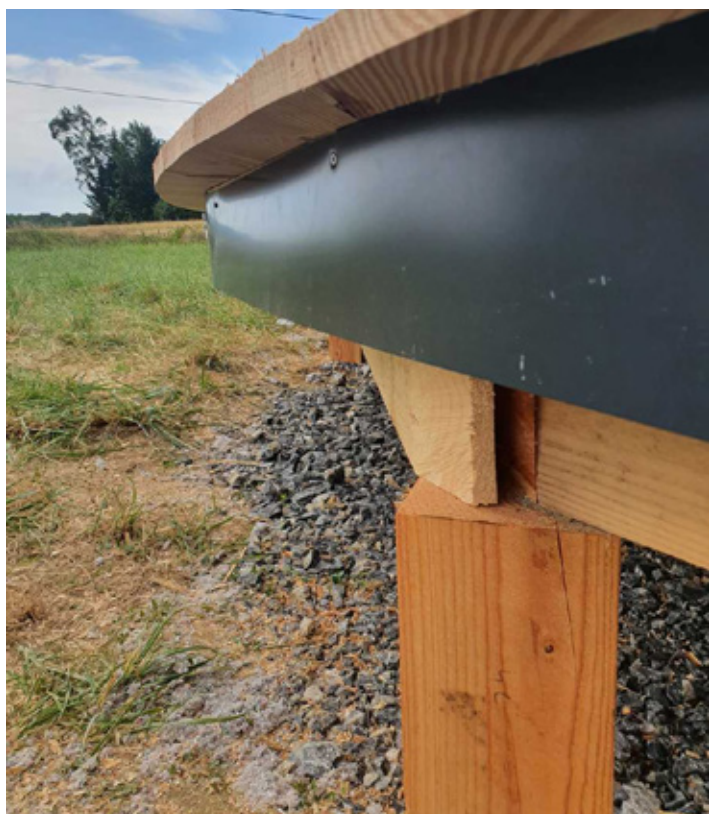
Protection du solivage bas par bac acier de 12 cm
