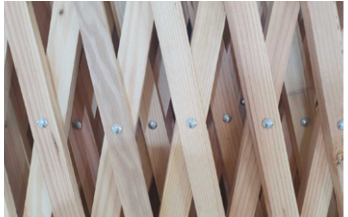
Fabrication d'un treillis en autoconstruction
