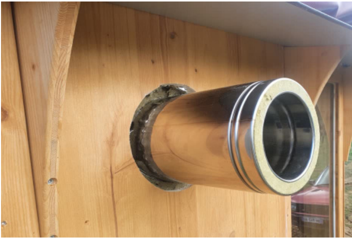
Sortie poêle à bois avec laine de roche
