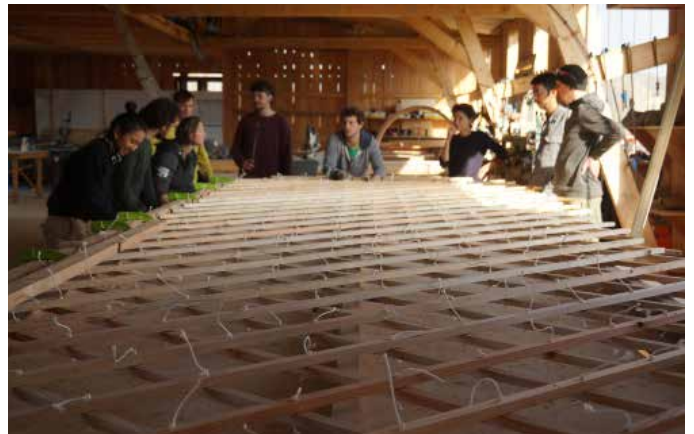
Fabrication d'un treillis en autoconstruction
