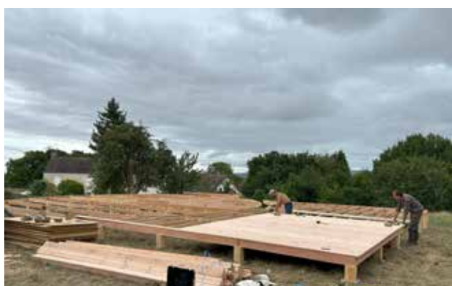
Fabrication plancher et terrasse
