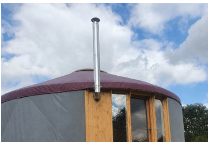
Sortie poêle à bois sécurisé
