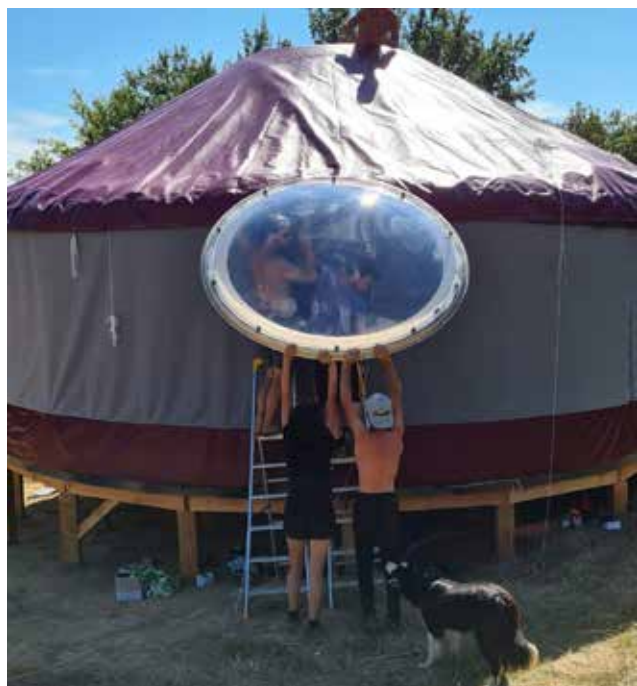
Installation d'une bulle plexi
