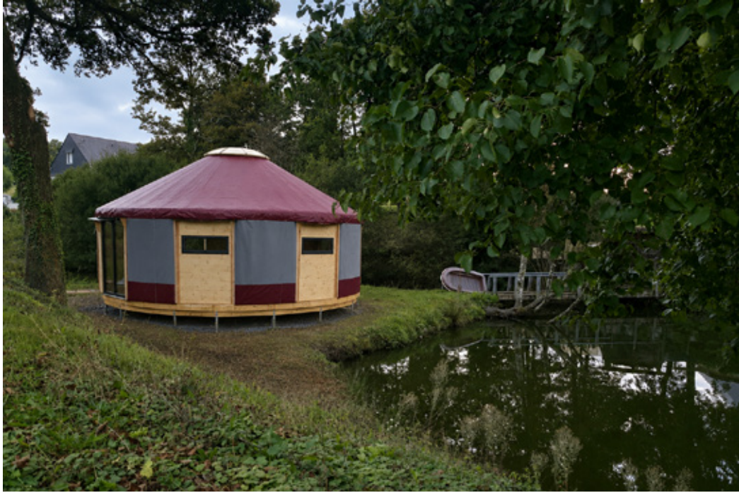
Une yourte de 7.5 m, fabrication yourte + plancher + montage : 14 jours
