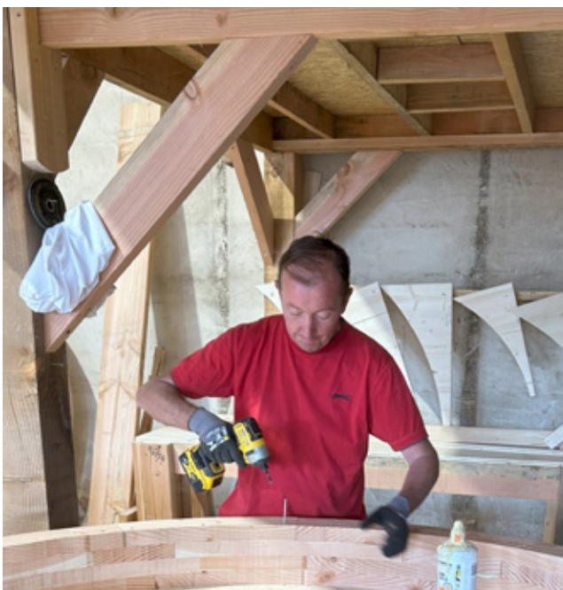
Fabrication d'un toono (couronne)
