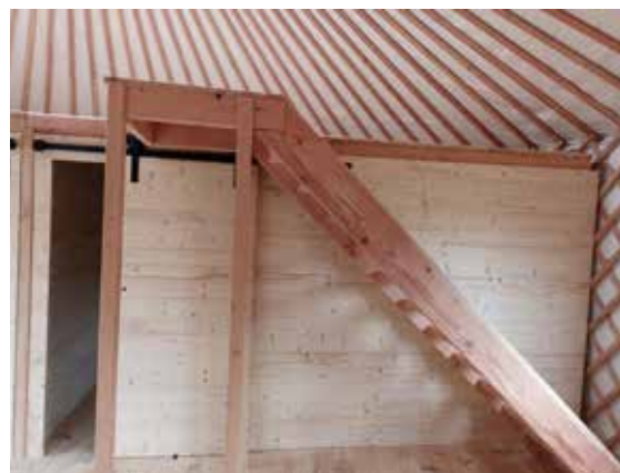
Porte à galandage et escalier de la mezza
