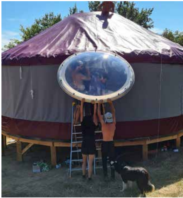
Installation d'une bulle plexi
