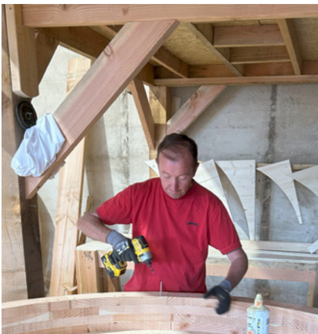
Fabrication d'un toono (couronne)
