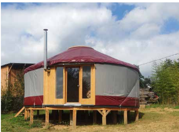
Sortie de poêle à bois sécurisé
