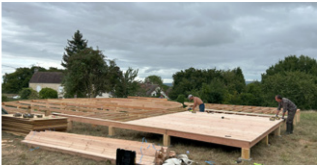
Fabrication plancher et terrasse
