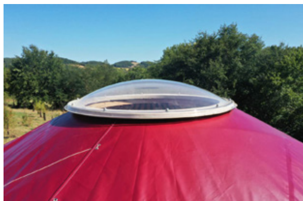
Toono ouvrant en Altuglas 2mm
