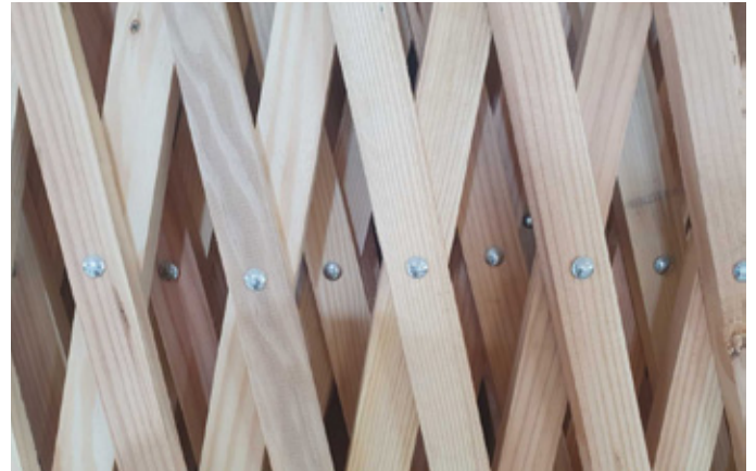
Fabrication d'un treillis en autoconstruction
