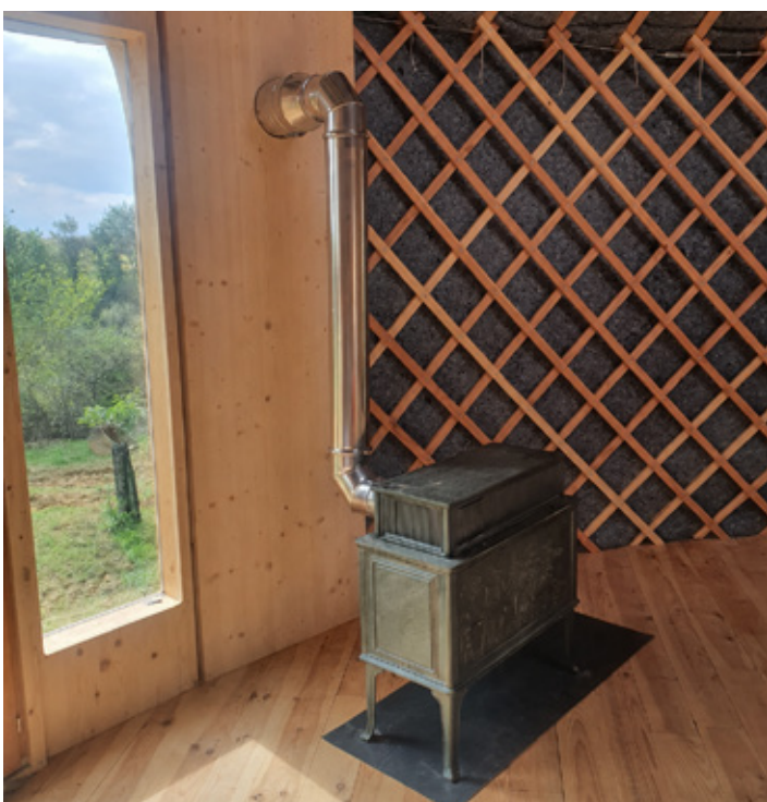
Sortie poêle à bois avec laine de roche
