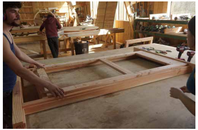
Fabrication des portes en autoconstruction
