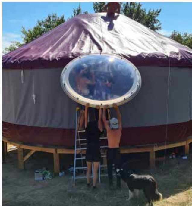
Installation d'une bulle plexi
