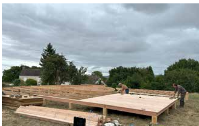
Fabrication plancher et terrasse
