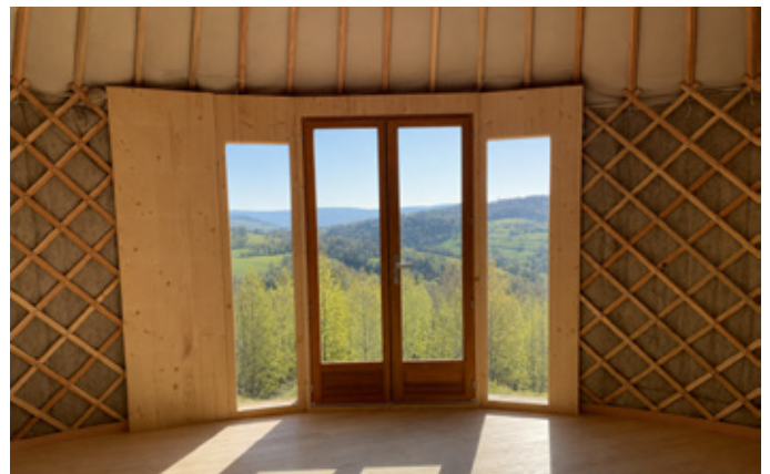
Porte double avec ventaux et module poêle à bois
