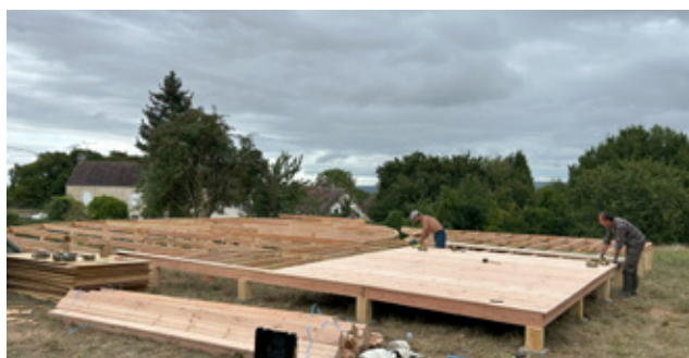
Fabrication plancher et terrasse
